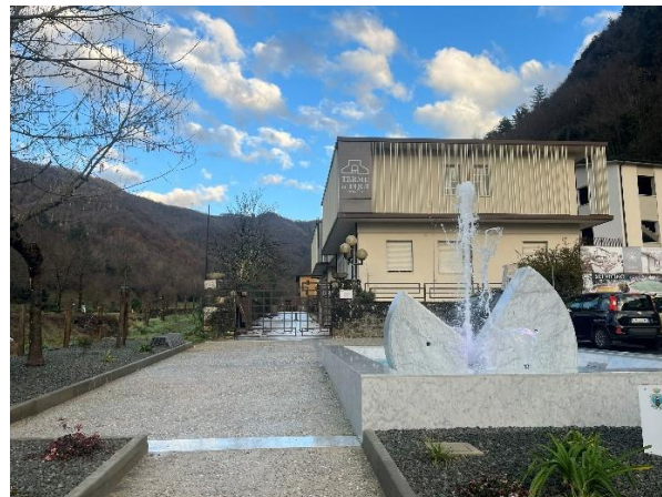
Figura 4 percorso sulla sinistra che conduce alle Terme
